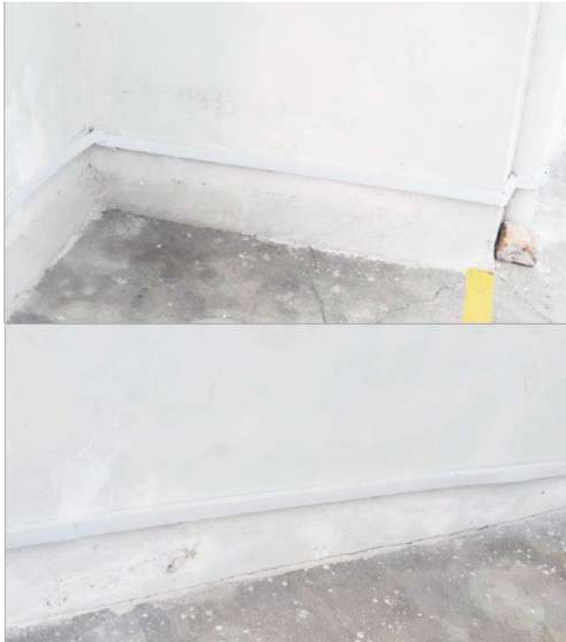
Colocación de canaleta de electrificación para el cuarto de refrigeración
