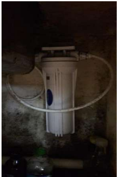
Mantenimiento de filtros de agua del Orquidario
