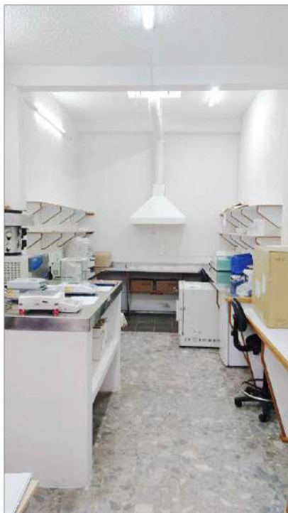
Colocación de barra de trabajo del laboratorio y electrificación del espacio
