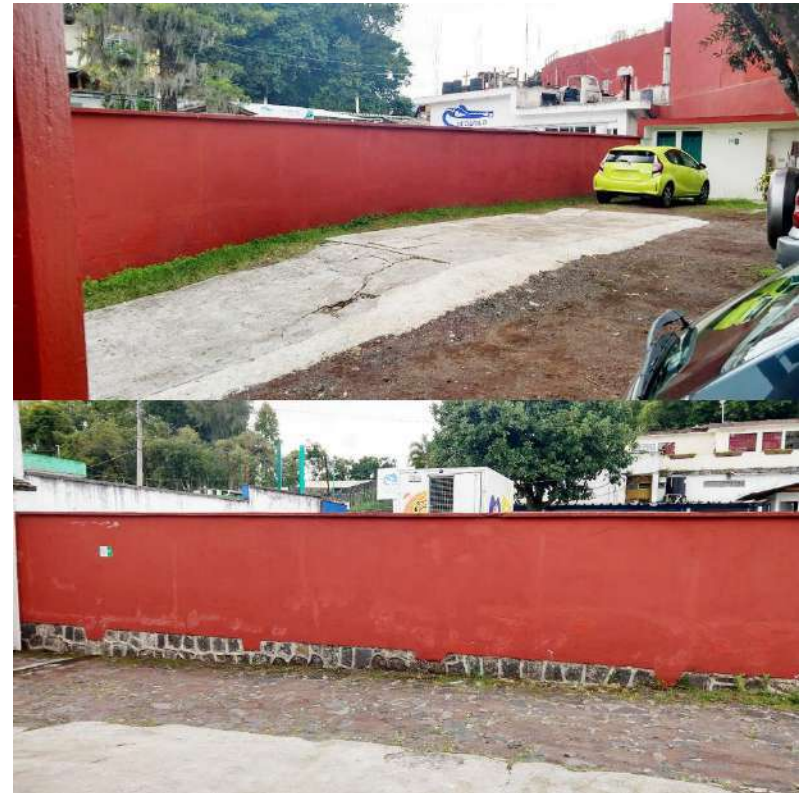
Mantenimiento de pintura en barda, estacionamiento
