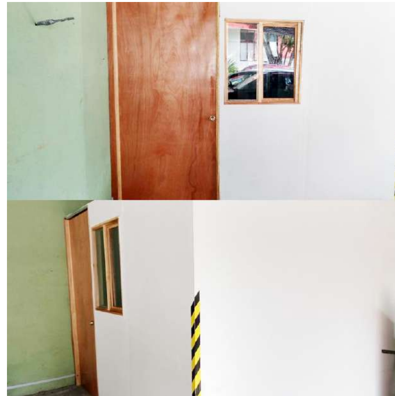
Construcción de cuarto de refrigeración
