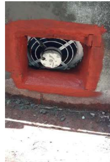
Colocación de extractor de aire e impermeabilización de muro
