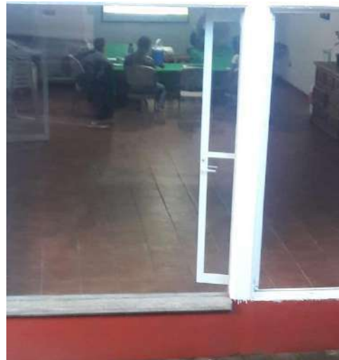
Pintado de fachada del salón .
