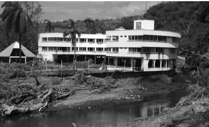
Necesario dragar los ríos, ya que al desviar sus afluentes se provoca una variación en los mantos friáticos que provoca inundaciones. (César Pisil)
